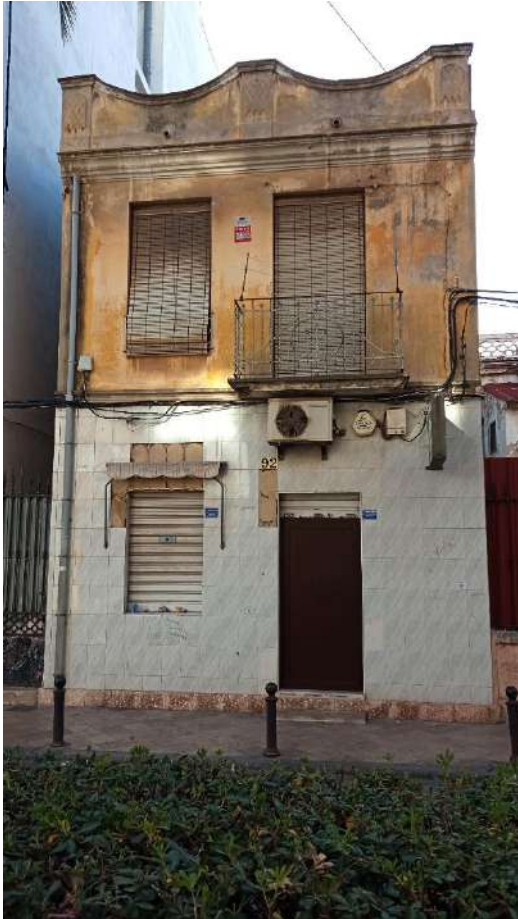
La casa en la que Doldi i la seua família passaren la riuada. Carrer D'alt de la Mar.
